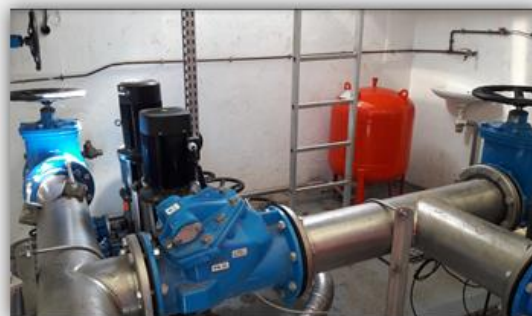
Reprise du réservoir de Magnitot
