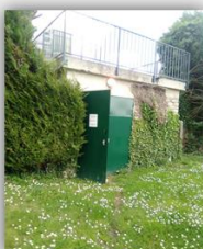
Réservoir de Omerville (capacité : 200 m³)
