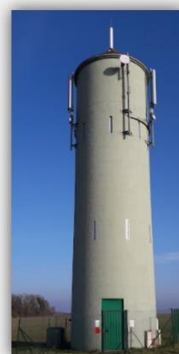
Réservoir de Ducourt (capacité : 70 m³)
