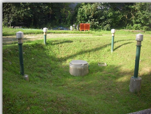
Bâche de la Flotte (capacité : 300 m³)
